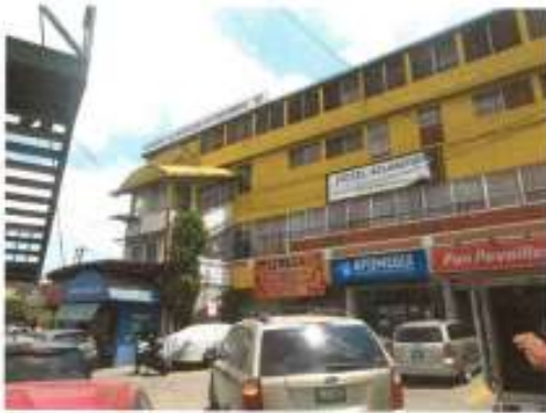
03 FRETE DEL CENTRO COMERCIAL
