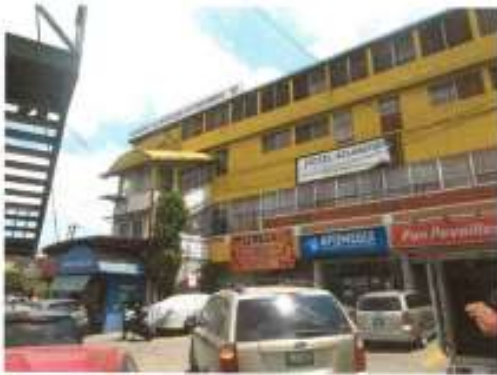
03 FRETE DEL CENTRO COMERCIAL
