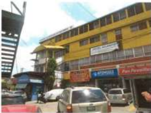
03 FRETE DEL CENTRO COMERCIAL
